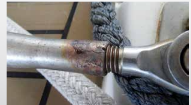
Haarrisse an den Wantenspannern sind Sollbruchstellen
